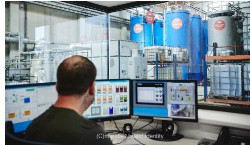
Behandlung Flüssige Abfälle
